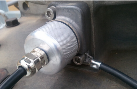
图9 现场未屏安装后的实物
