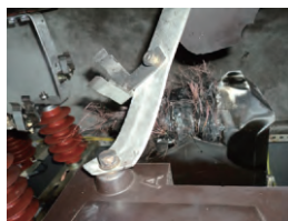
图1 C相电压互感器烧化
