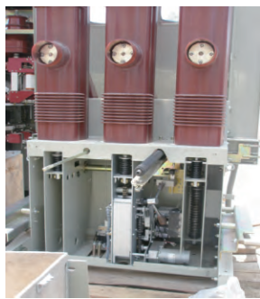
图5 直线位移传感器安装位置
