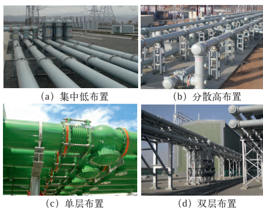
图5 几种典型的GIS母线布置
