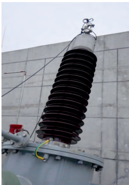
图5 套管出线夹钳
