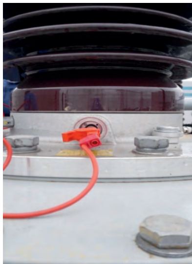
图3 套管末屏连接
