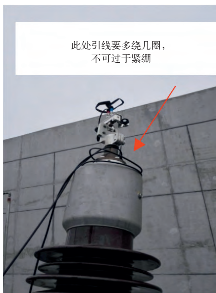
图6 套管出线夹钳近图
