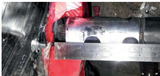
图7 量取线芯压接尺寸
