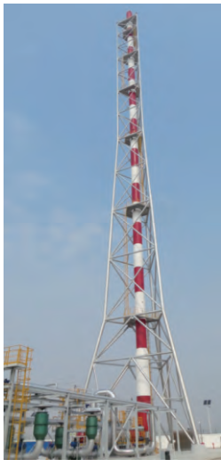
图 1 塔架式烟囱现场照片
