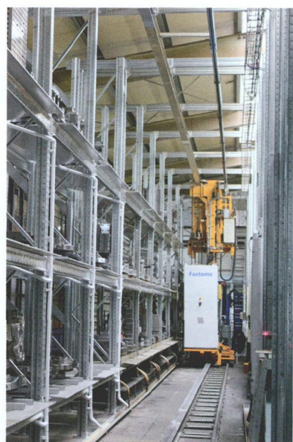
图 3 两台新的加工中心集成到一条柔性生产线中，共计 53 个工位
