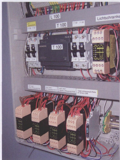
图2 这种安全控制器可以监控49个动态安全传感器或紧急停车键
