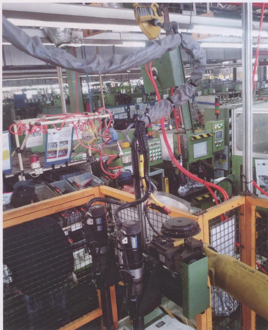
图1 改造前线缆悬挂于与机器人上方，结构复杂，也不美观，并且磨损极大
