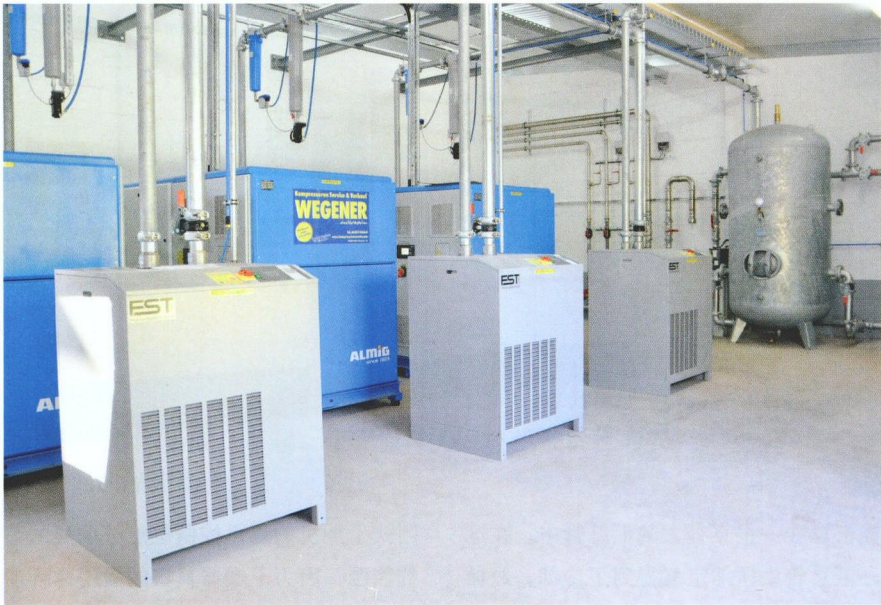
图 2 三台 Variable 系列的螺杆式空气压缩机满足了负载变化的要求。压缩机后安装使用的是 FST 公司研发生产的前级过滤器和后级过滤器、压缩空气冷干机和吸附式干燥机
