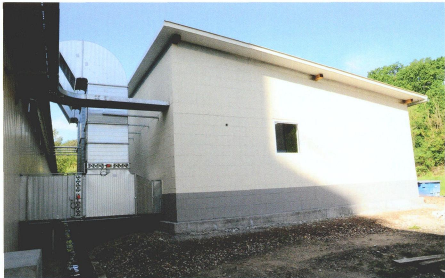
图 4 EKW 公司为新的空气压缩机建造了新的空压机站
