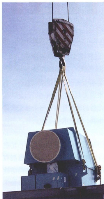
图1 一台风力发电机正在进行拆卸和更换
