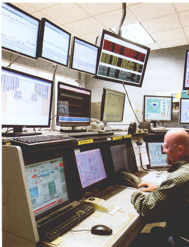
图 2 P3000 吹灰优化系统可以与现有分散控制系统并行安装
