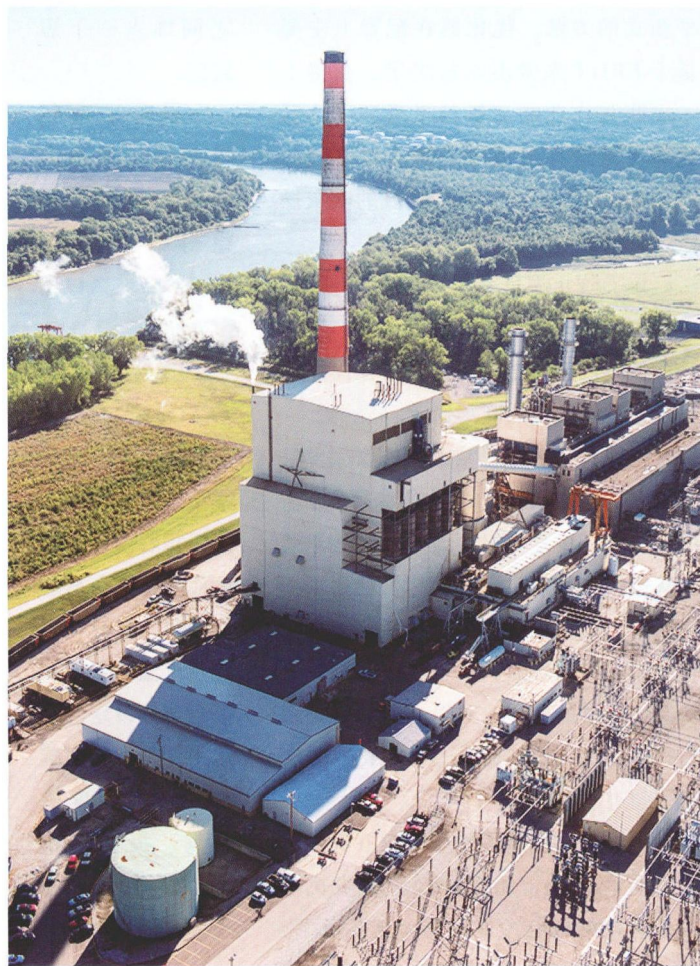
图 1 堪萨斯市电力电灯公司 (KCP&L) Hawthorn 发电厂最近对其吹灰过程实施了一次综合改造
