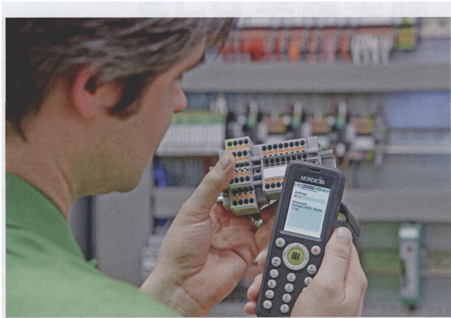
图 4 使用手持式 RFID 可视化的定位标记展示出开关箱的接线板的精准安装位置
