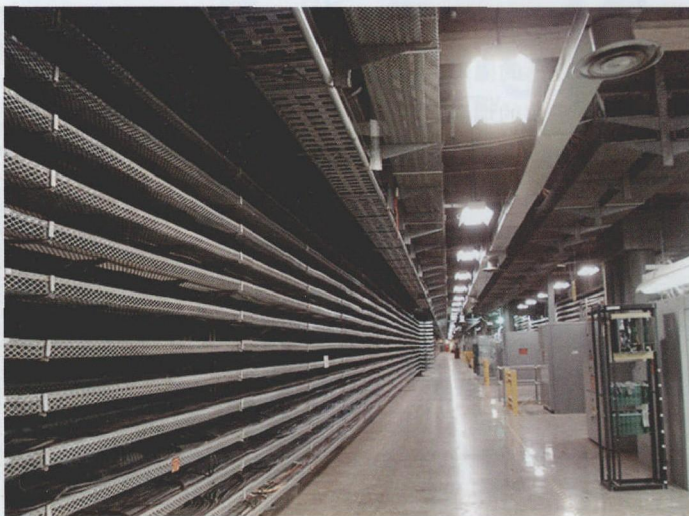
图2 为数众多的垂直布设的宽敞而堆叠的电缆桥架代表着具有挑战性的火灾预防状况
