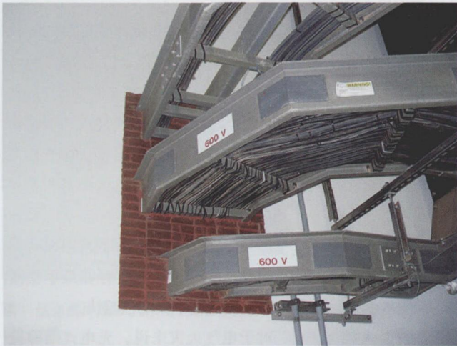
图3 就该这样做！这个电缆桥架在穿过墙壁布设时安上了正确的挡火装置
