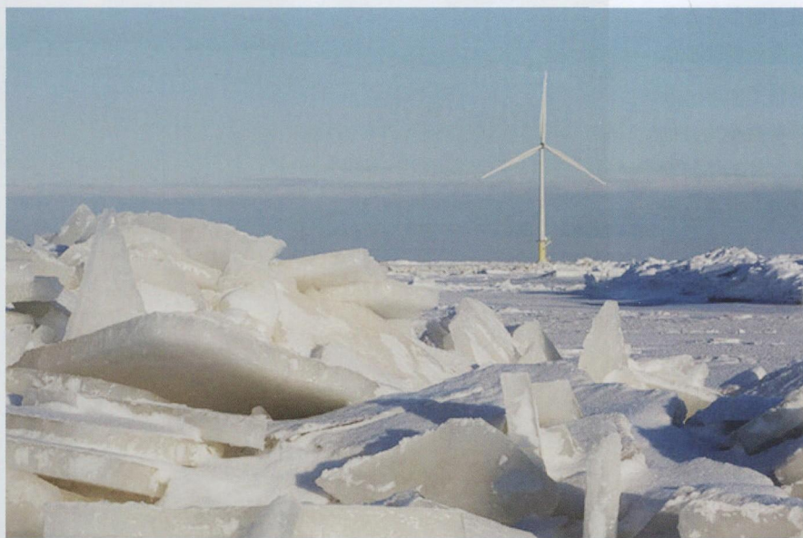
图 1 处于大量浮冰之中的风轮发电机，这个基础包括一个轻质钢外壳和一个环形基脚、破冰锥和碎石填料
