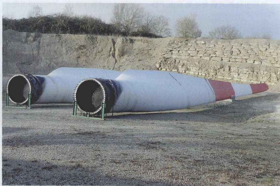
图 1 拆除因雷击而受损的风力发电设备。不久之后大型 GFK 玻璃纤维增强材料零部件的拆卸和销毁将不再是偶发事故的原因了，第一代风力发电设备将开始退役
