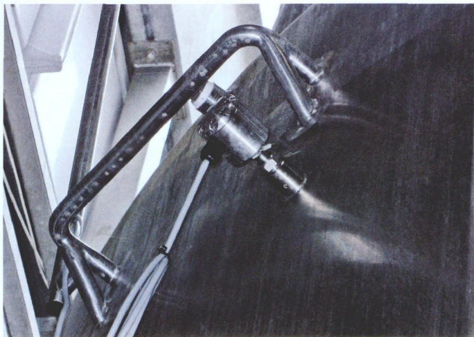
图 2 CleverLevel 开关用于检测酵母罐的液位
