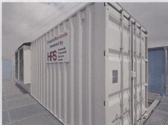
图3 集装箱式空压站置于生产车间屋顶是理想方式
