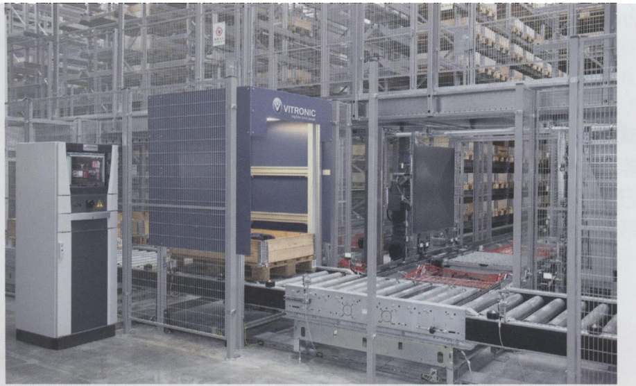
图 1 自动化小件仓库（AKL）使 Grob 机器设备生产厂的小材料件仓储位置利用率更高、灵活性更好
