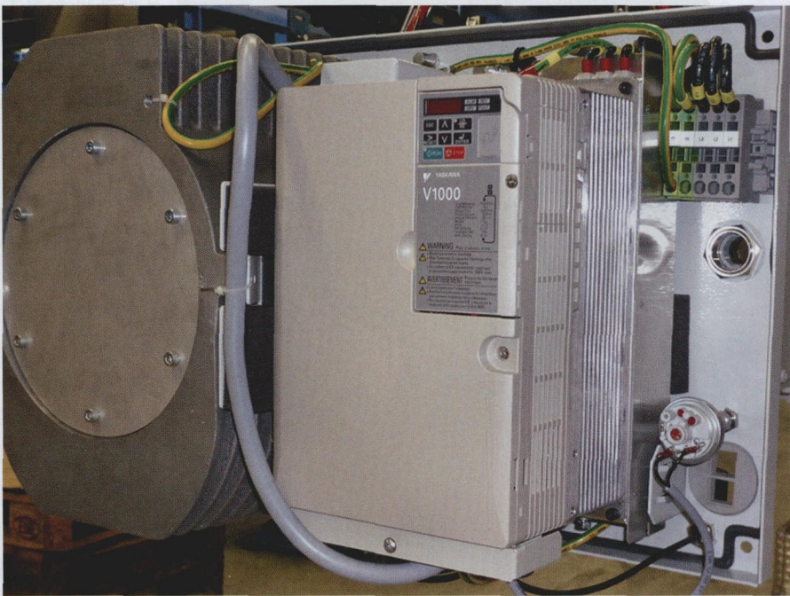
图 2 利用变频器可以根据实际需要准确地调节泵和压缩机的工作
