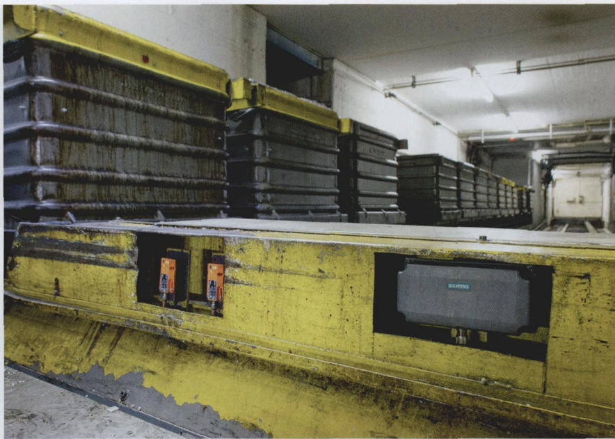
图 4 Simatic RF380R 型 RFID 阅读器检测转发器寄存的废弃材料容器的号码并将容器控制到一个正确的路线中
