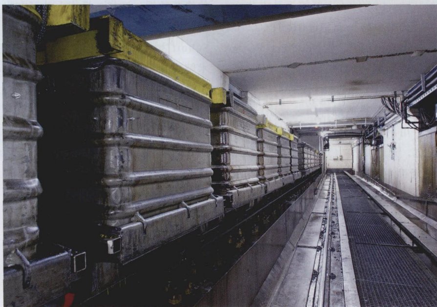
图2 采用新的控制装置和使用 RFID 识别，可更加灵活的分类收集多孔板加工生产过程中产生的废弃材料
