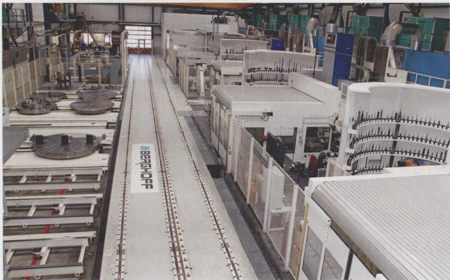
图 2 从托盘交换站（左）的调度岗位出发，操作人员可以直接从设备上对带有工件的托盘进行调度
