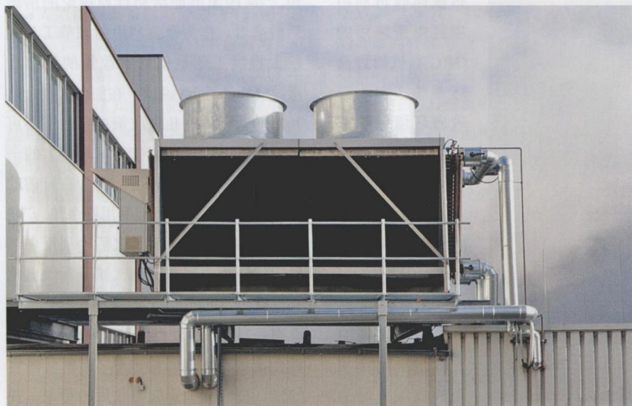
图1 Schersal 公司新型制冷设备能够在工作时产生较高的制冷温度、省略使用冷水
