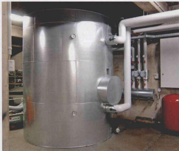
图 3 首次在 Täfler 公司中发挥效益的 1 × 10 4 l 的热能存储器
