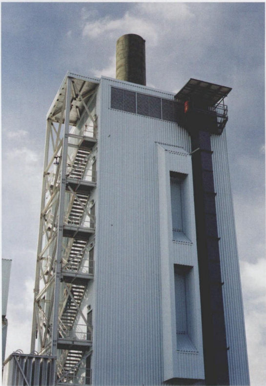
图3 建筑四周有许多百叶窗，可以利用风冷作用
