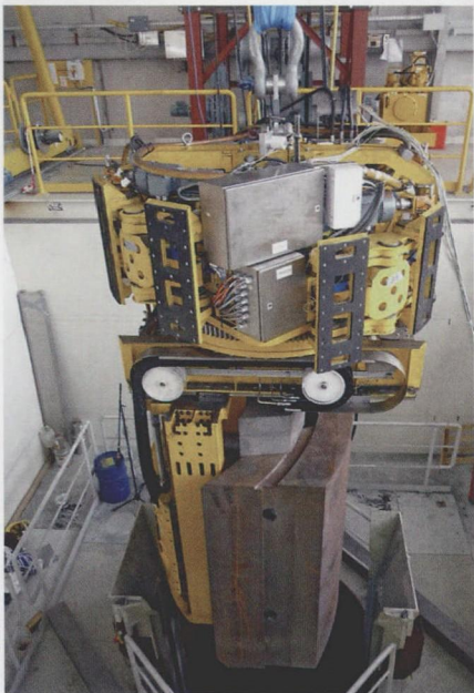
图 2 为拆除几吨重的反应堆防护壳，需要专用的起重工具，这里要利用远程遥控的钻削设备钻孔，完成一个防护壳部件的固定和起吊
