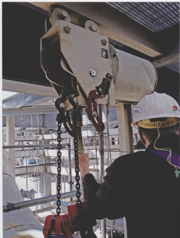
图2 在低负荷运行前，管道工程师要对管道吊架进行评估
