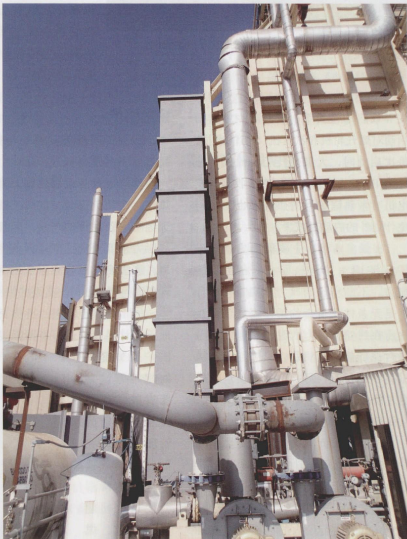
图1 在这座发电厂中，在包含一台通用框架 7FA 燃气轮机的 CC 机组中，系统将低温环境空气送入进口排气
