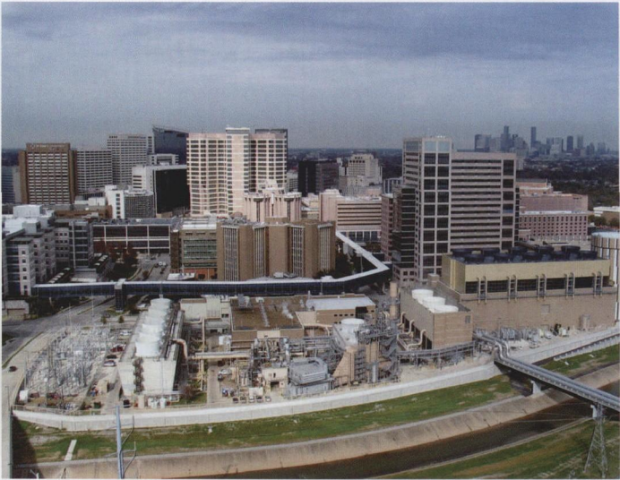
图 4 通用电气的 LM6000-PDSprint 航改式燃气轮机帮助世界上最大的医疗中心，休斯顿的德克萨斯州医学中心供热、制冷和供电
