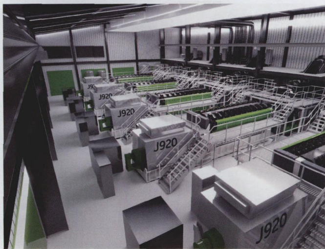
图1 6 个 J920FleXtra 天然气发动机将用于 Sky Global Partners 在德州的一个 51.2 MW 的发电厂，这座发电厂将向 San Bernard Electric Cooperative Inc. 提供灵活的供电方案，5 min 启动时间和 49% 的供电效率
