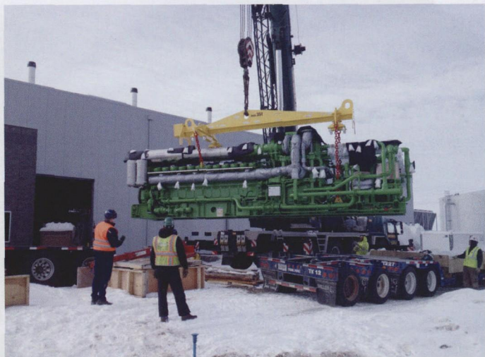
图2 3 套 J624 发动机将用于位于密歇根州的 13 MW 的 Coldwater 工厂，发电厂将提供灵活的供电
