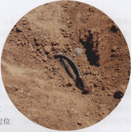
图 3 对于埋地电缆来说，拼接和终端故障非常常见，通过采用常见方法就能识别和定位故障，包括过低频率、高势能和局部放电测试
