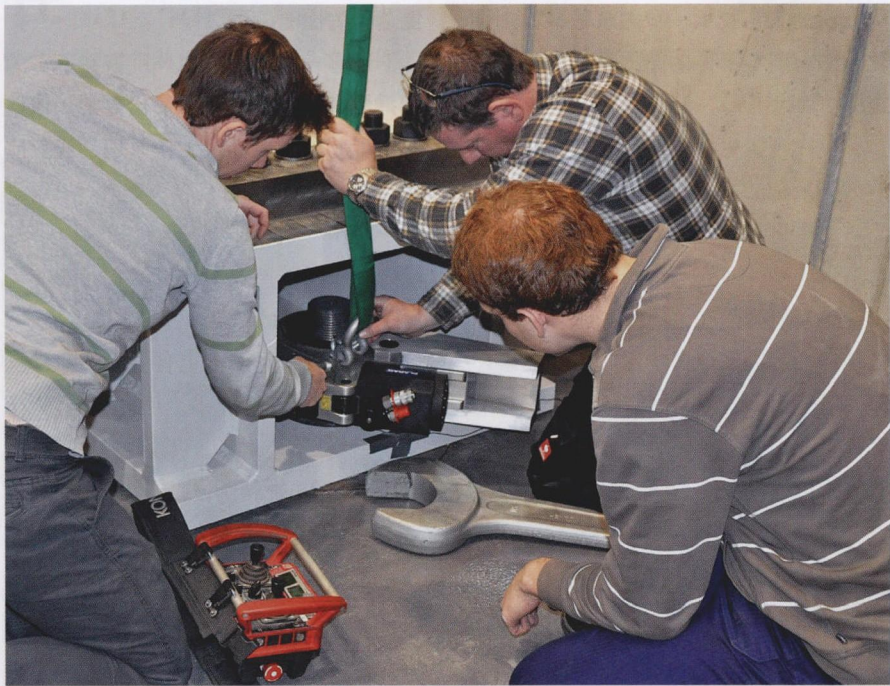
图 1 庞然大物专用的螺栓，Plarad Wagner 公司为亚琛 RWTH 高等技术学院风力发电检测中心的风机检测设备，设计了专用的螺栓拧紧设备
