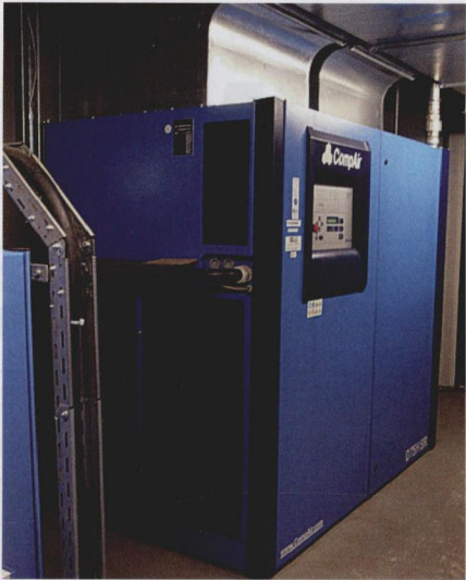
图 4 Rohde & Schwarz 公司购置的新型 Pureair 无油空气压缩机
