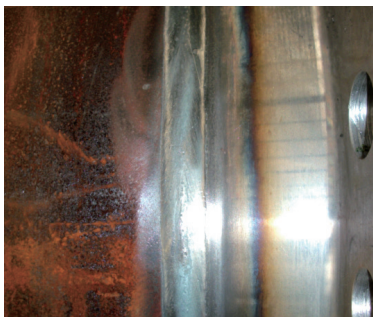
图5 大口径钢管与法兰对接焊缝
