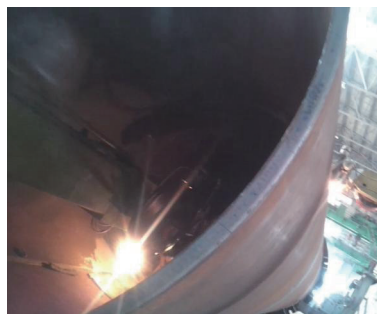
图1 筒体内外环缝同时同步焊接
