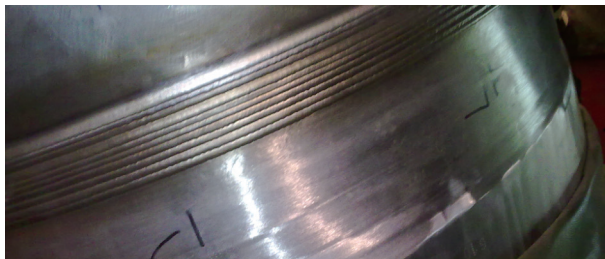
图9 U1口焊缝外观
