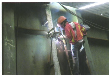
图12 小车填充及盖面腹板对接
