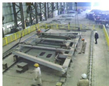
图9 焊接完成后横隔板翻身
