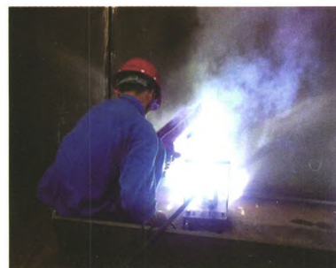
图5 无盲区焊接小车焊接技术
