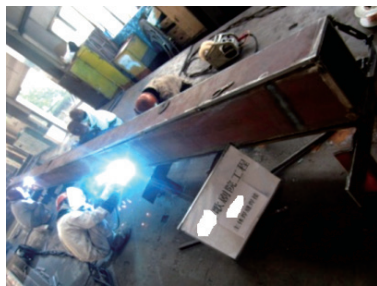
图6 主体焊缝焊接
