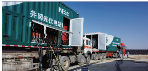
图7 LVRT现场检测试验
