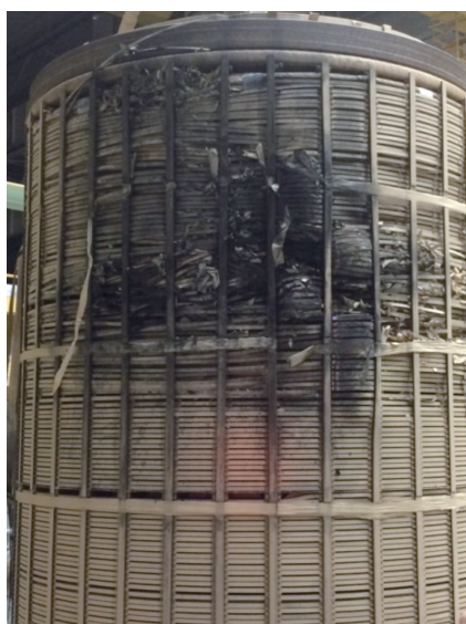
图4 1号主变压器B相吊罩检查图
