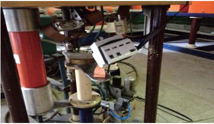
图5 熔断器与SPD现场的接线图
