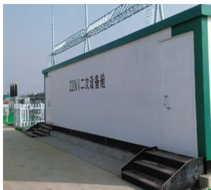
图9 舱门与站内地面衔接示意图
