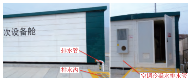
图10 舱体排水管的配合
