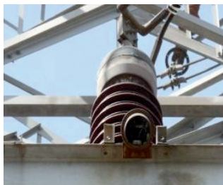
图1 故障避雷器
