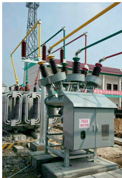
图19 ZHW17-40.5复合式组合电器
