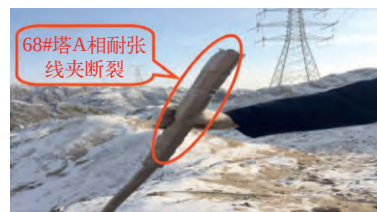
图2 68#塔A相耐张线夹断裂
