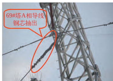
图1 69#塔A相导线钢芯抽出
