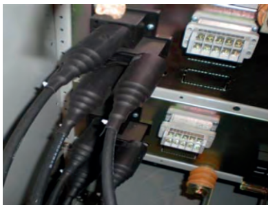
图4 出线电缆采用无卤低烟阻燃绝缘罩
