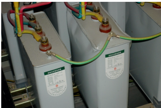
图1 谐波导致的电容器鼓胀图
