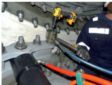
图1 拆卸变桨油缸
