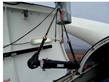
图3 吊变桨液压缸
