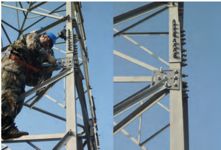
图3 现场安装照片
