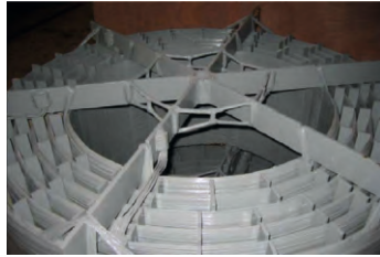
图1 干式空心平波电抗器
