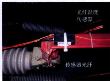
图5 光纤传感器安装位置
